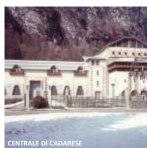
CENTRALE DI CADARESE
